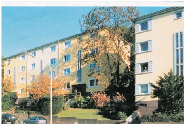
Schöne Fassaden mit ThermoShield-Schutz in der Wuppertaler Siedlung
